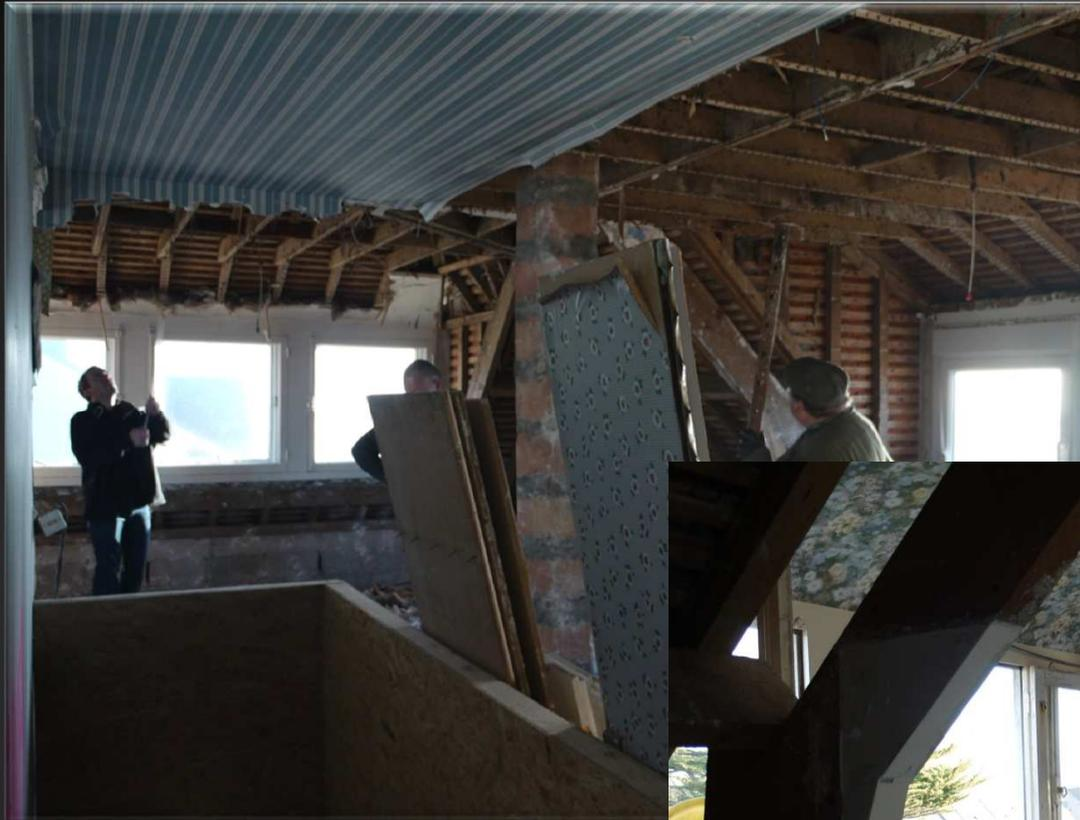
Prise de cotes du charpentier dès que l'essentiel de la charpente se trouve mise à nu.
