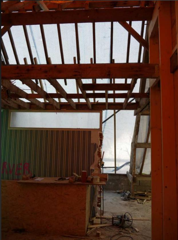
Les réservations sont ménagées dans la charpente maintenue en place afin d'y placer les éléments principaux de l'étage que sont les lucarnes
