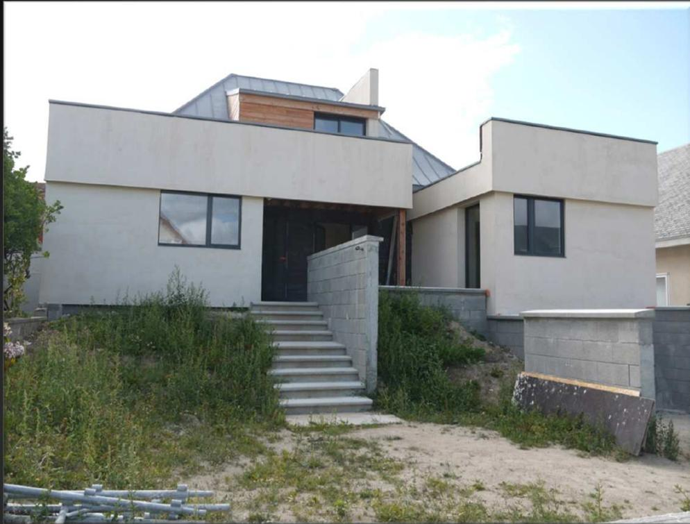
La fibre de bois doit être rapidement protégée par un sous enduit à base de chaux. Son épaisseur doit être conséquente afin d'assurer une protection mécanique suffisante, une toile rigide est incorporée.
