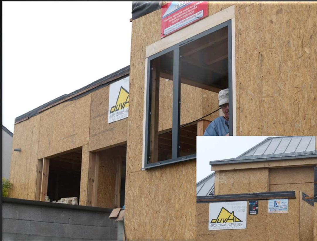
Pose des menuiseries extérieures, après le hors d'eau, bientôt le hors d'air et le travaux de second œuvre intérieur.
