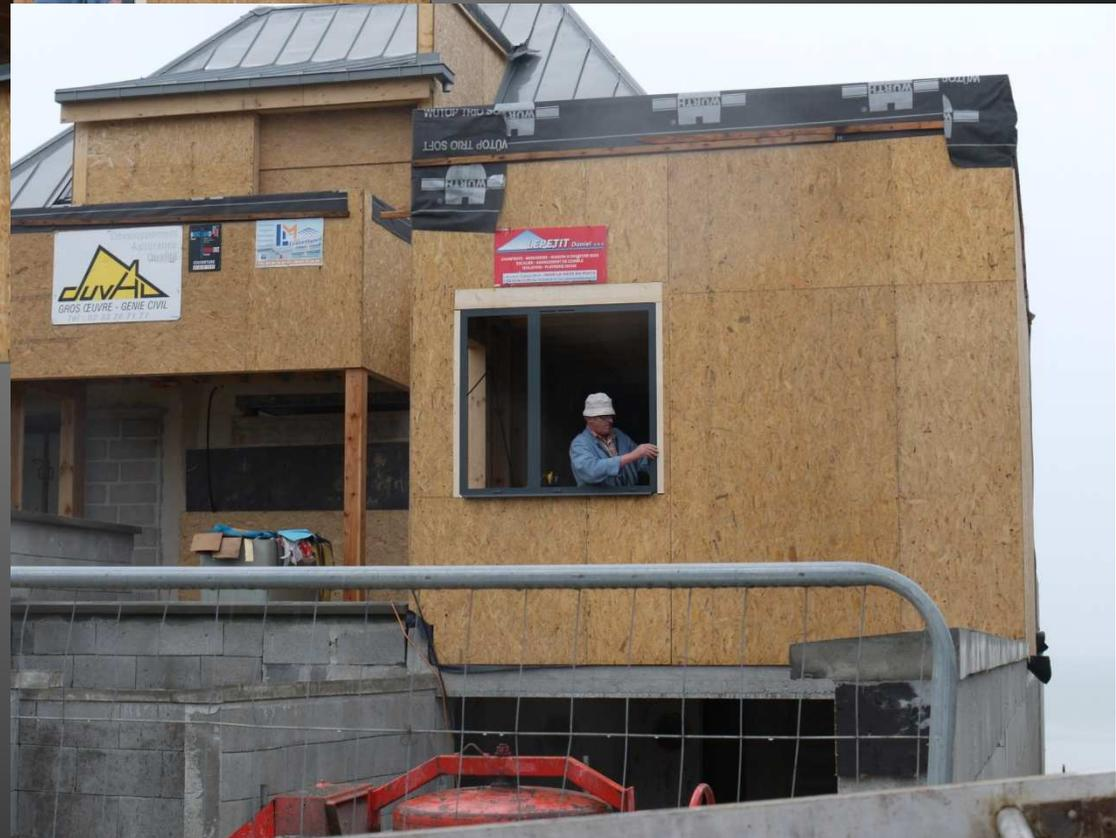
A la différence d'un mur en béton, les réservations dans un mur bois peuvent être modifiées. La continuité du matériaux bois est assurée.
