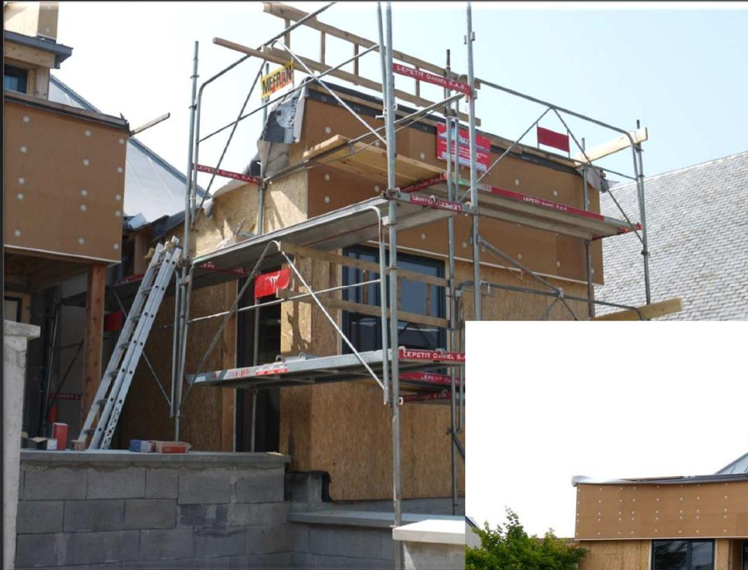
L'entreprise LEPETIT met alors en œuvre l'habillage des éléments d'ossature bois : pare-pluie avant la bardage ou la fibre de bois support d'enduit et complément d'isolation.
