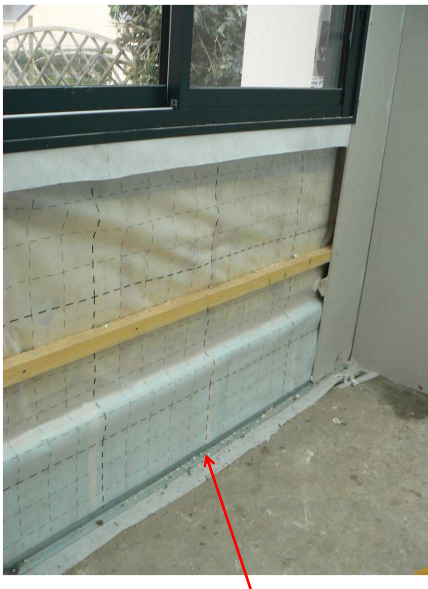
Disposition pour le test infiltrométrie intermédiaire
